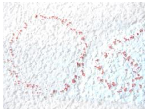
Echantillon après test de la bille à 60 joules avec Fema Armature Blanche et 2 couches d' Enduit Novo .
