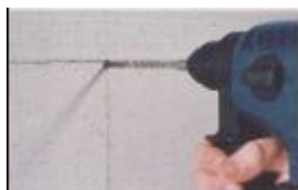
1) Perçage de l'isolant.
